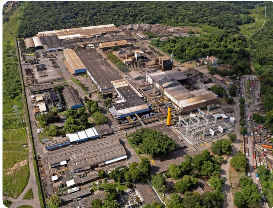
Açonorte mill, Recife (PE)
