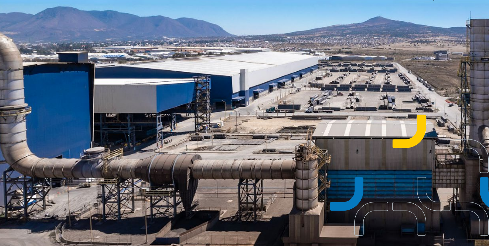
Sahagún mill, Mexico
